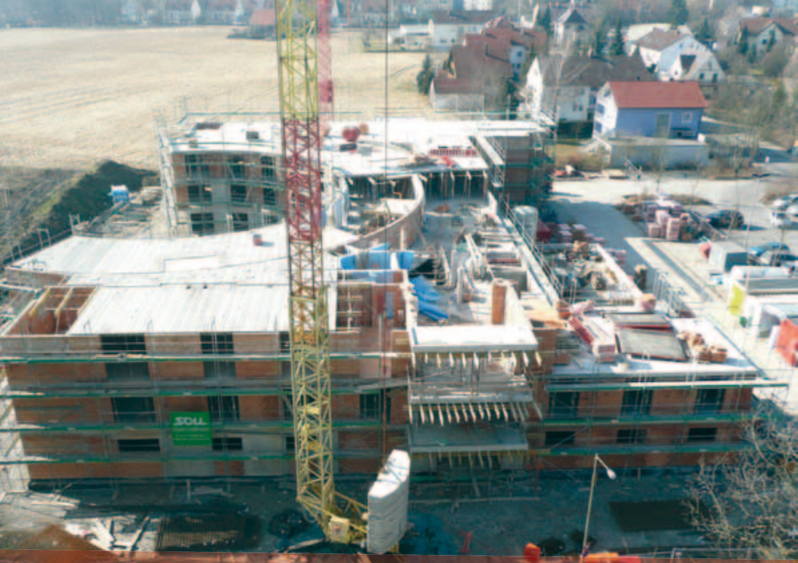
Neubau Seniorenwohnheim Haunstetten
